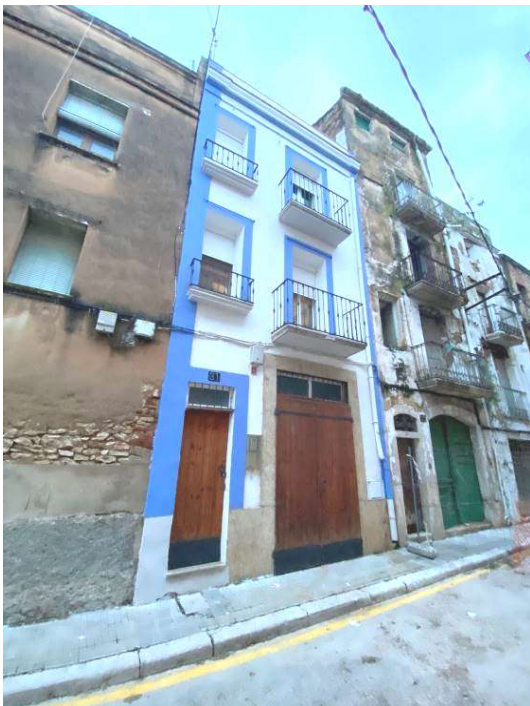
Carrer Sant Antoni 31, edifici en bon estat aparent
