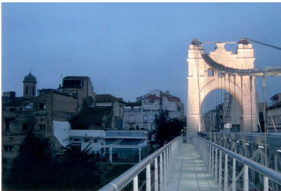
Foto del Pont Penjant d'Amposta. Fons Fernando Albiol Palacio
