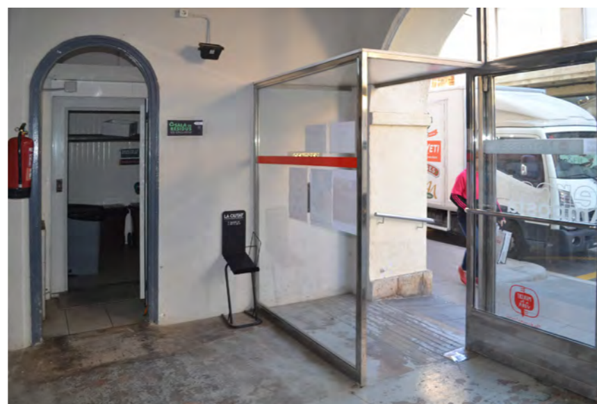
Accés des del Carrer Tarragona
