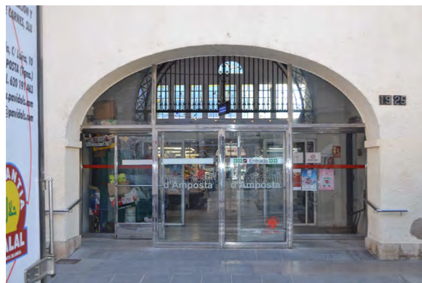
Façana Carrer Tarragona
