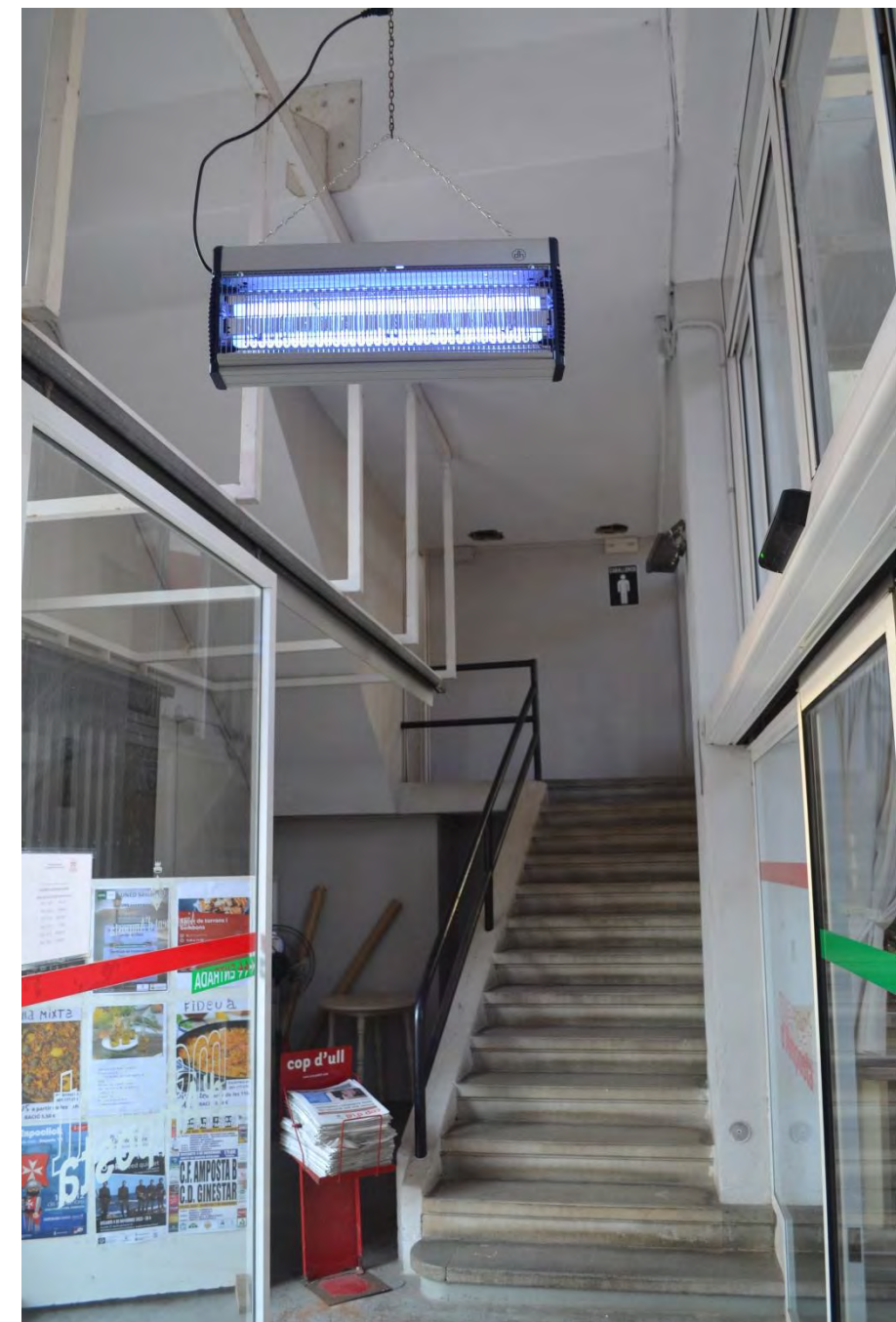
Hall d'accés per avinguda Alcalde Palau. Escales accés a planta primera on son els banys. Mampara mòbil a l'esquerra amb el sistema de subjecció de les guies fixat a sostre.
