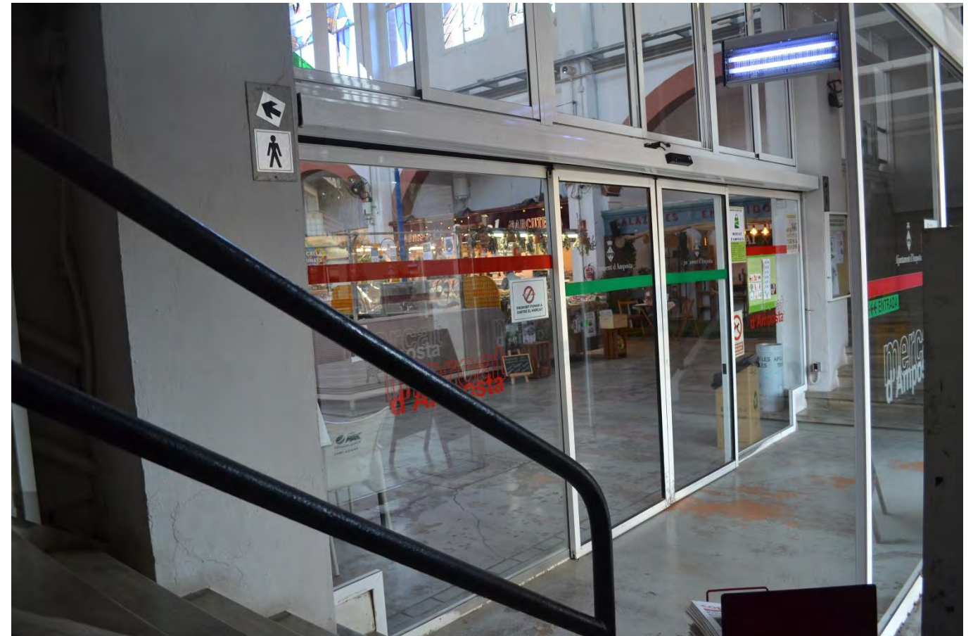
Porta interior automàtica accés avinguda Alcalde Palau.
