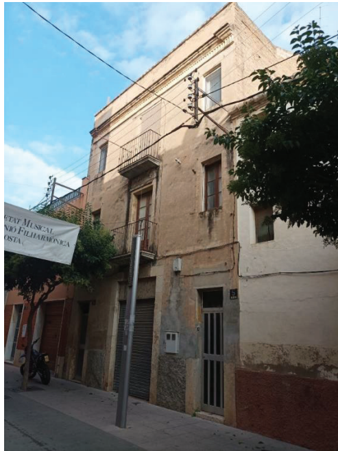
f1_façana principal Miralles, 5
